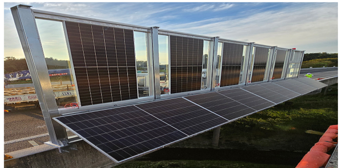
한국도로공사 여주시험도로, 태양광 및 인프라 방음벽(후면)
